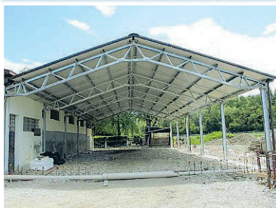
Struttura metallica portante fase di montaggio
